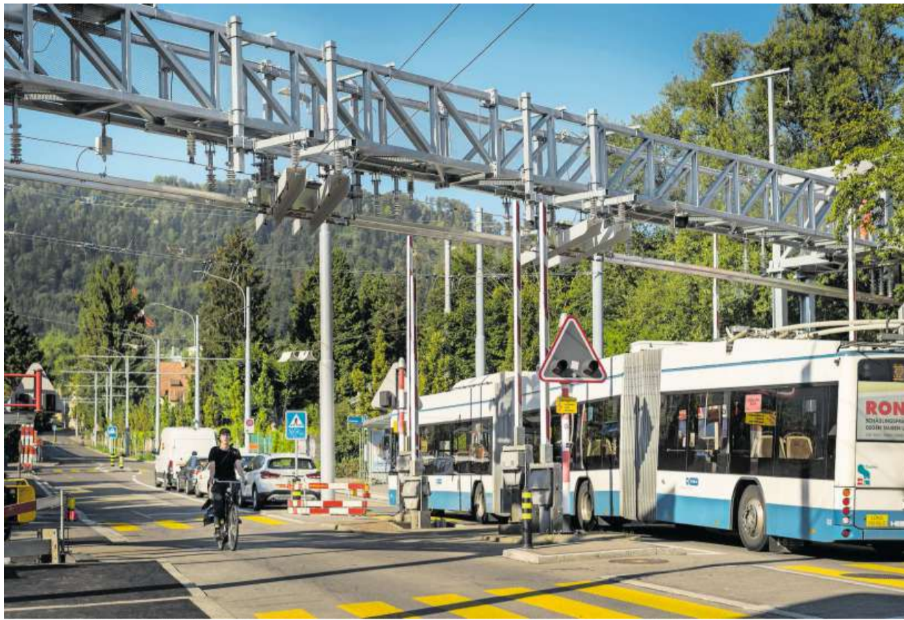
Das Stahlgerüst überspannt die Friesenbergstrasse und ist 33 Meter lang. Anwohner nennen es «Monster».
