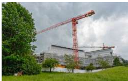
JUNI 2014 Renovationsarbeiten am Fusse des Üetliberges, die Giardino Group nimmt den Hotelbetrieb wieder auf.
