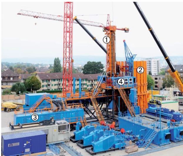
Bohranlage Triemli im Aufbau, 2009
